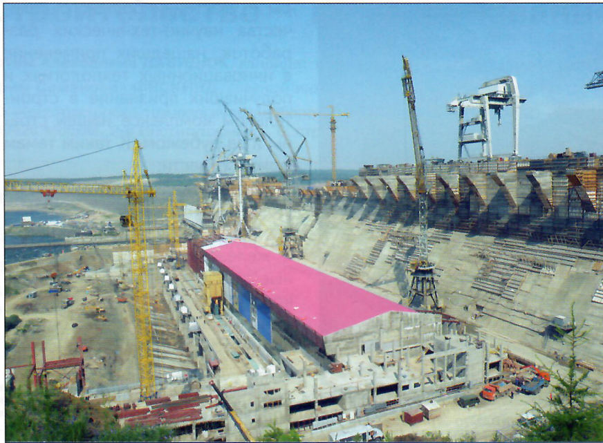
Техническая экспертиза выполненных объемов строительно-монтажных работ на предмет соответствия проектной документации при строительстве Богучанской ГЭС
