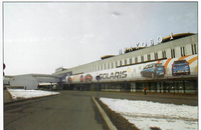
Техническое обследование аэропорта «Пулково-1», Санкт-Петербург
