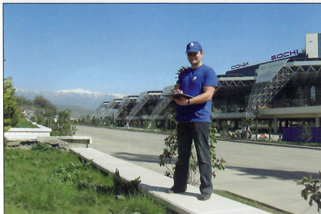
Техническое обследование и пространственный расчет строительных конструкций международного аэропорта г. Сочи
