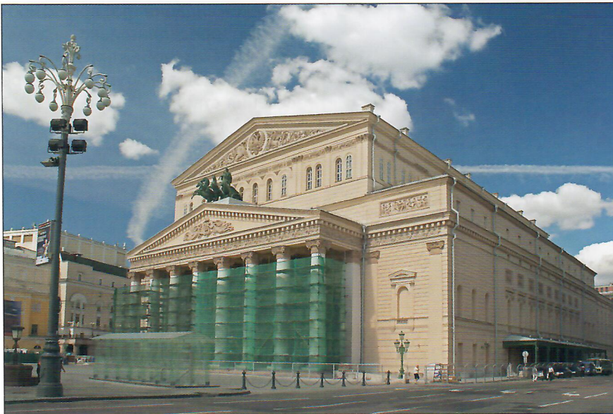
Техническая экспертиза и сопровождение строительно-монтажных работ при реконструкции Большого театра на предмет соответствия проектной документации
